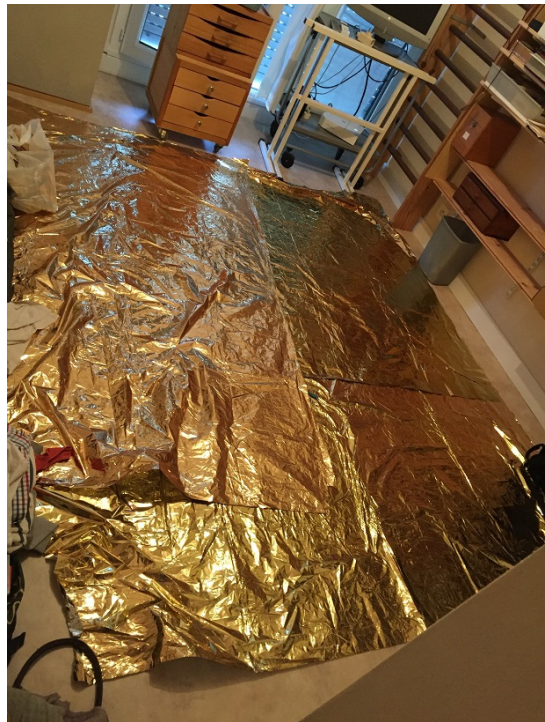
Recouvrement du sol : au moins 4 couvertures de survie, face argentée vers le sol et face dorée vers le haut
